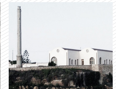
Fig 2.8 Tonnara di Capo Granitola
