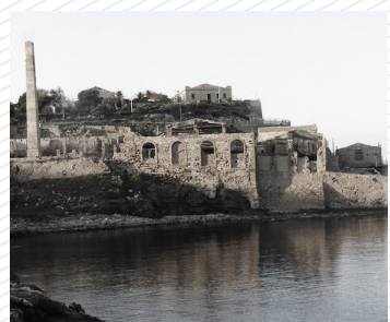
Fig 2.1 Tonnara di Portopalo
